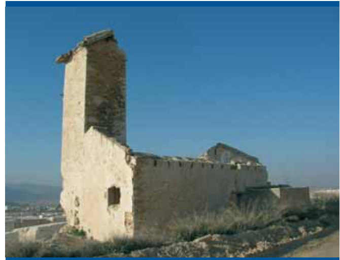
Pozo de acceso a La Mina (L'Alguenya)
