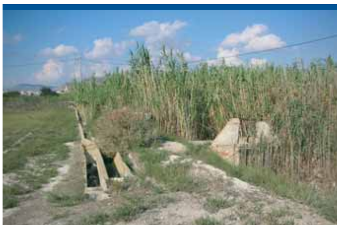
Partidor y acequias de distribución sobre uno de los hilos de la huerta de Villena, en desuso.
