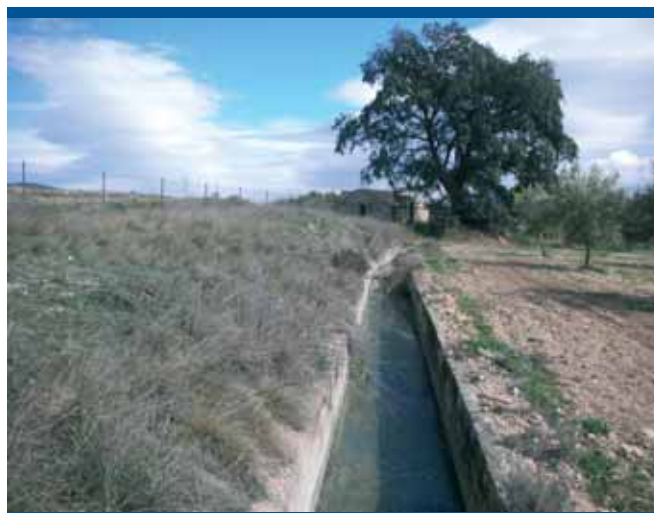
Acequia principal a partir de la cual se derivan los caudales a los regadíos de la Vall de Benejama
